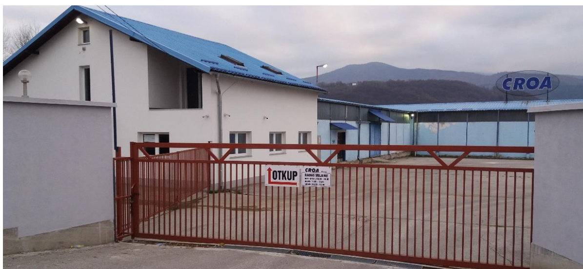
Slika 2. Poslovni objekat (hala i administrativni dio) za recikliranje otpadnih akumulatora i metalnog otpada, sa ulaznom kapijom i vanjskim manipulativnim prostorom u krugu
